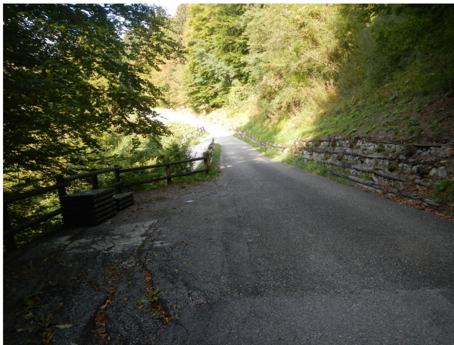
F2) palificata mista fatiscante verso monte e cedimenti evidenti verso valle.
