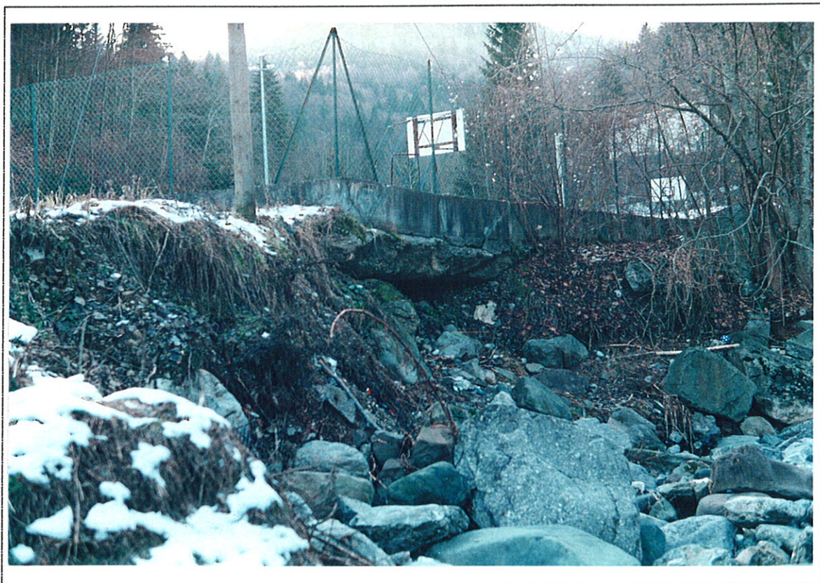
Foto 5. Località Vinaio. Scalzamento del muro di recinzione del campo di pallacanestro
